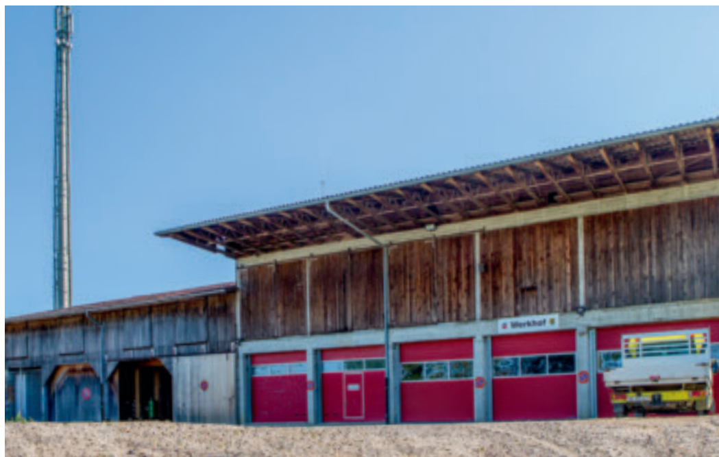
Im neuen Werkhof von Lyss (links) lagert sämtliches Material der Gemeinde. Die Werkhöfe von Grossaffoltern und Rapperswil BE (oben) arbeiten gemeinsam.
