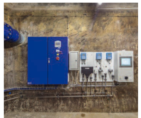
Automatisierte Qualitätskontrolle im Wasserreservoir «Niggidei»
