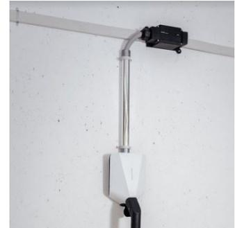
Es ist weder ein FI Schutzschalter (ein RCD Typ B 30mA AC / 6mA DC bereits in Ladestation integriert) noch ein separater Leitungsschutzschalter pro Ladestation notwendig.
