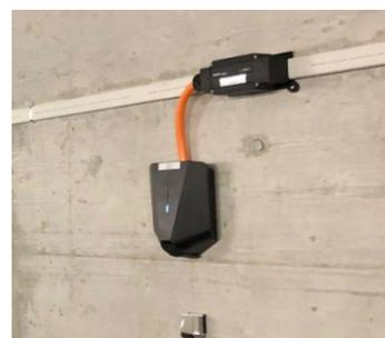
Alternativ kann der Anschluss mit einem 5x10mm<sup>2</sup> Cu-Kabel erfolgen, dabei ist für eine kurzschluss sichere Verlegeart zu sorgen:
