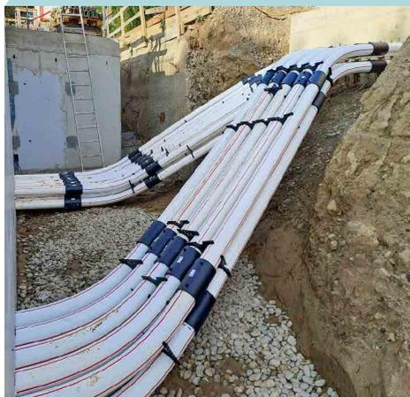
Umfangreicher Rohrblock mit Strom- und Telekomkabeln zur unterirdischen Trafostation.
